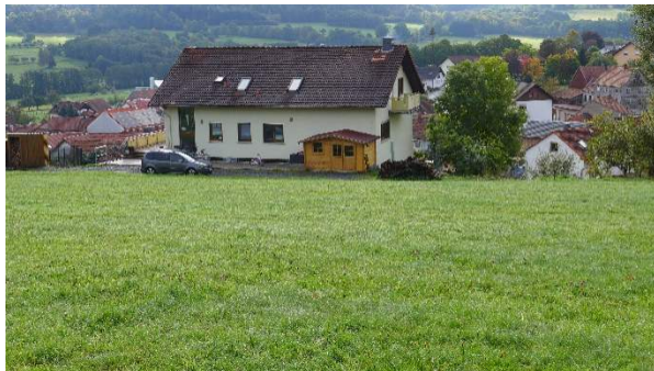
Blick nach Norden auf das Plangebiet (Wiese) mit südlich angrenzender Bestandbebauung
